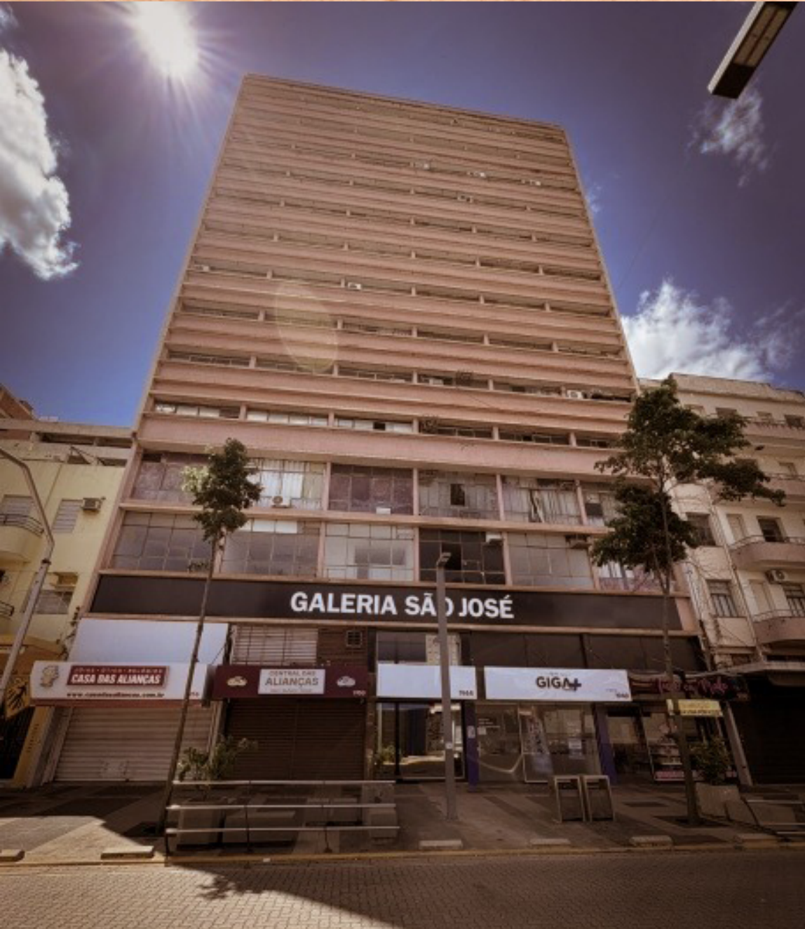
Edifício Irmãos Salomão - Galeria São José.
