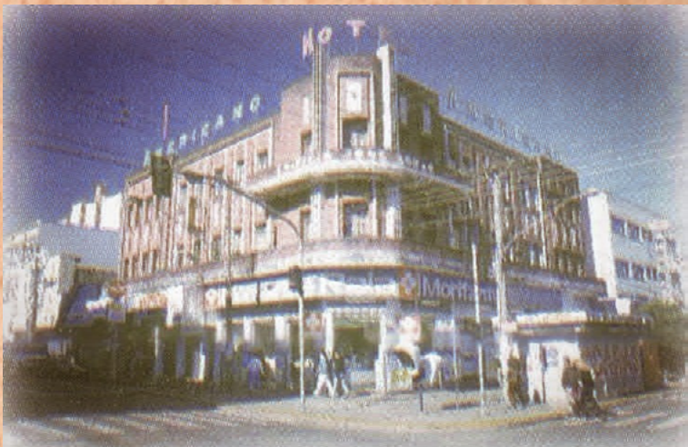
Edifício José Abrão - Hotel Americano, 1998. Fonte Arruda (2002).
