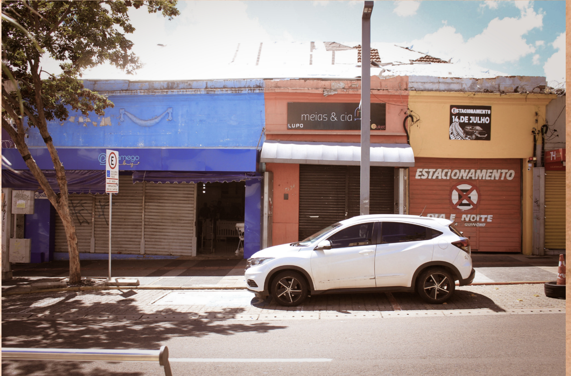
Edificação Platibanda Ornamental com Guirlanda.
