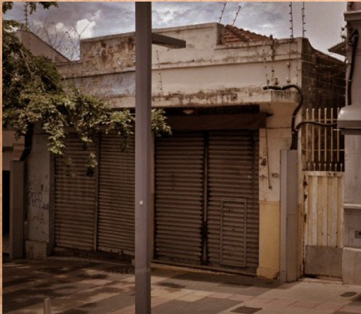
Edificação com Frisos.
