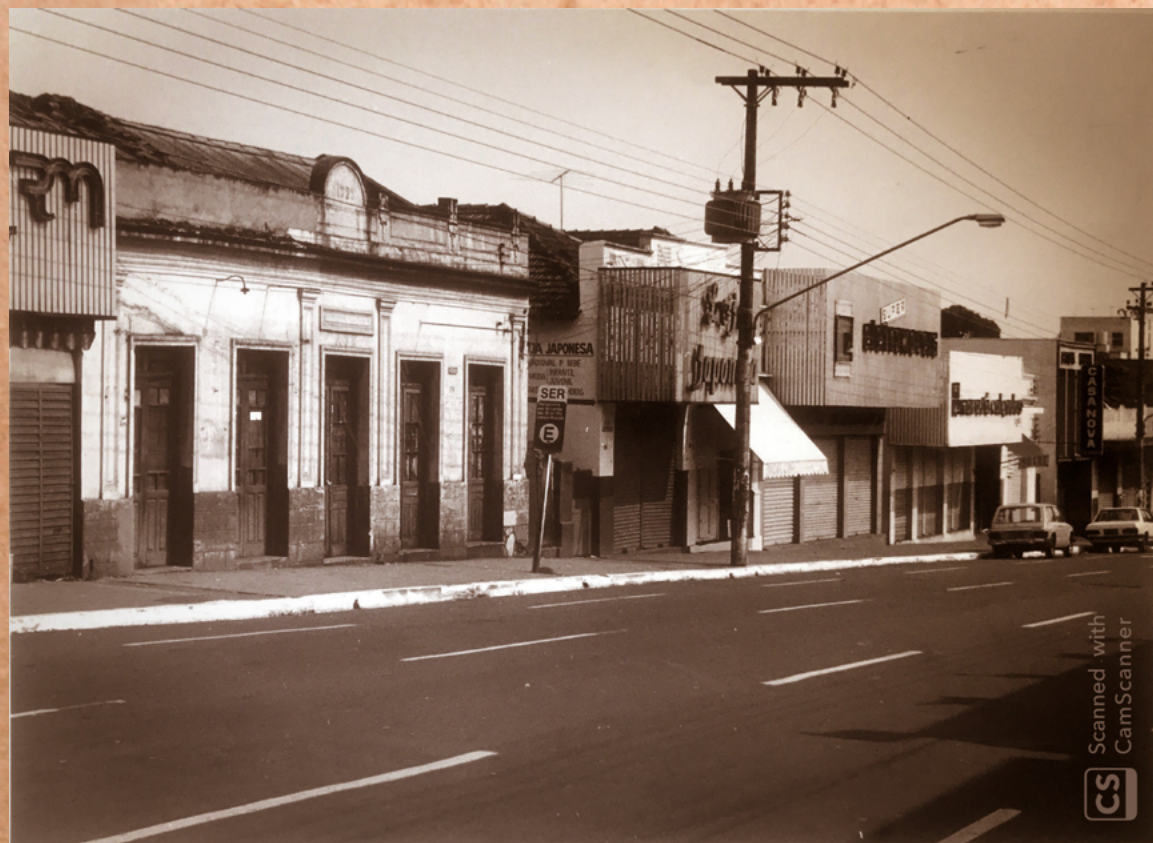
Edifício do coroamento geométrico com recobrimento publicitário da Loja Japonesa. Acervo ARCA, novembro de 1990.
