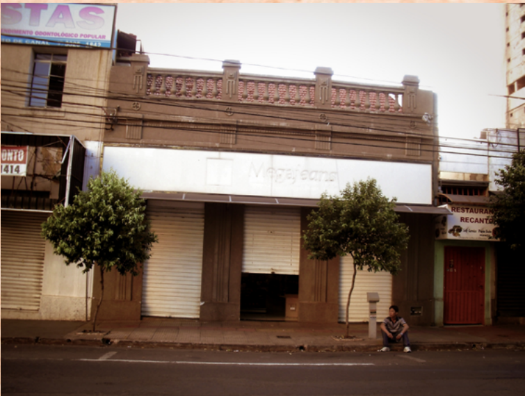
Reconstrução do imóvel que abrigou a antiga Gráfica Gutenberg após demolição indevida. Fotografia Fernando Batiston, 2012.
