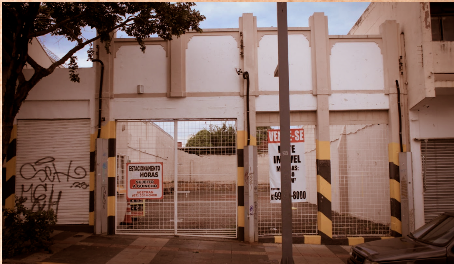
Edificação com Pilastras.
