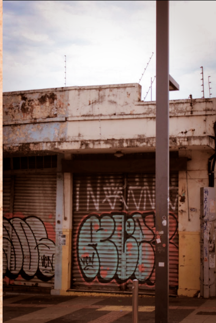
Edificação com Frisos - vista atual.
