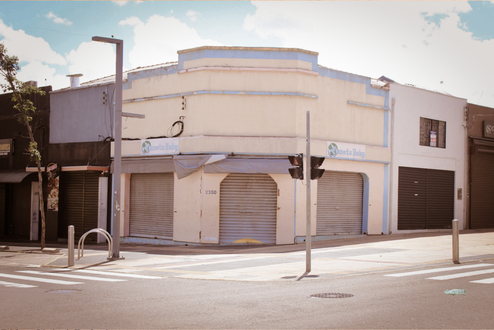
Edificação Platibanda Escalonada.
