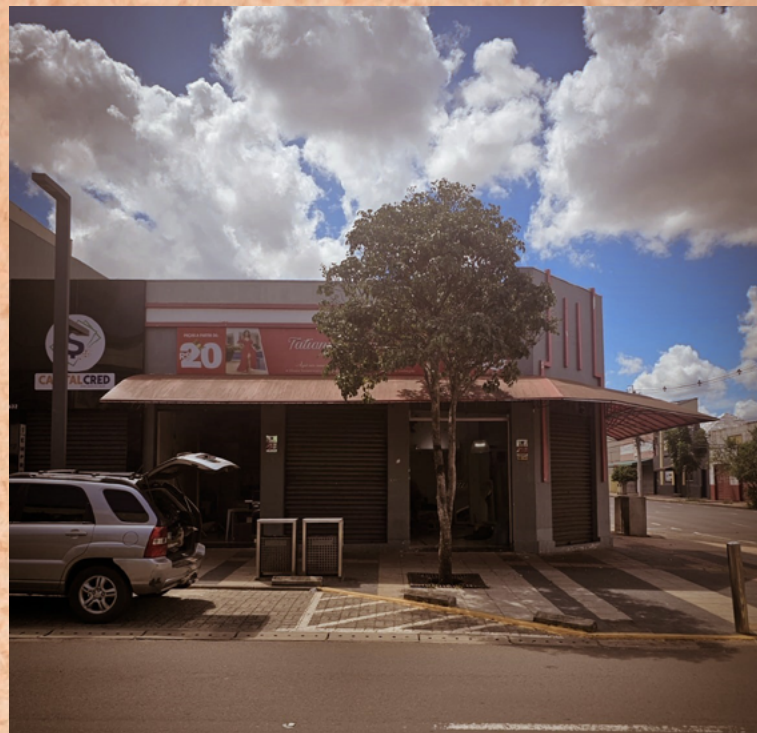
Armazém João Domingos - vista lateral.
