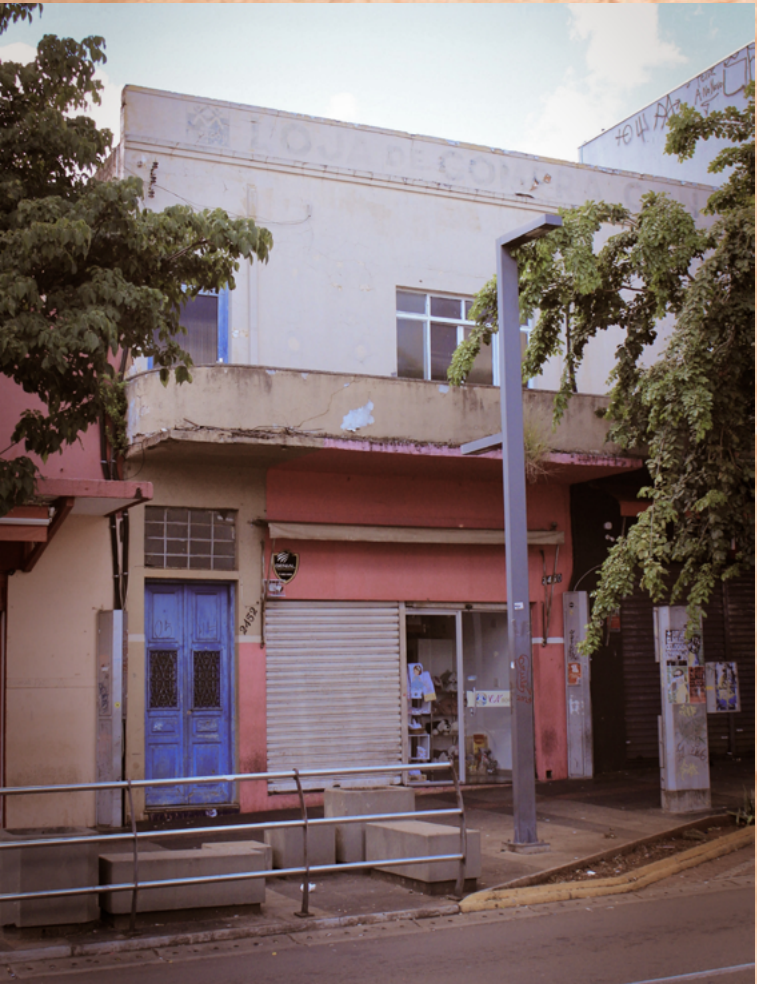
Sobrado Sobreesquina com Sacada - vista lateral esquerda.
