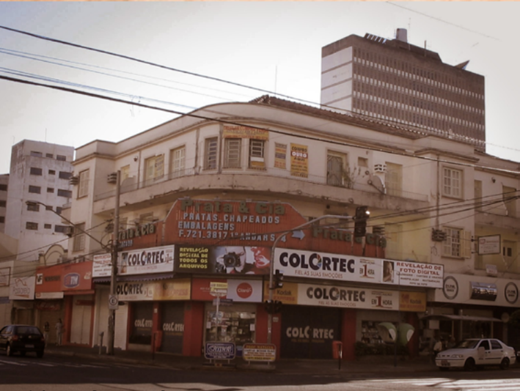
Edifício São Félix. Fonte Batiston (2007).
