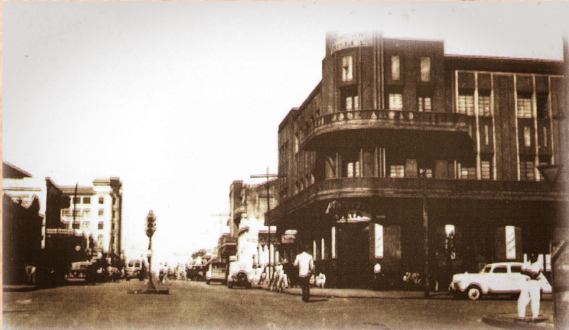
Edifício José Abrão - Hotel Americano, 1952. Fonte Arruda (2002).
