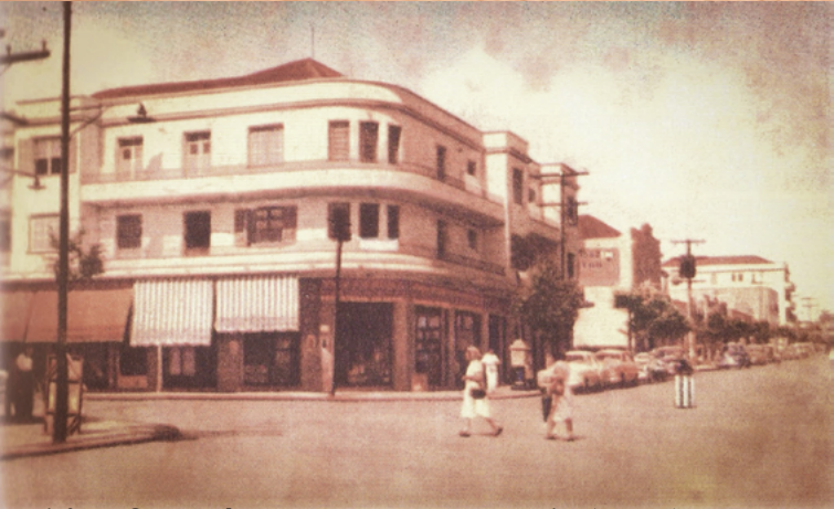
Edifício São Félix, 1949. Fonte Arruda (2002).
